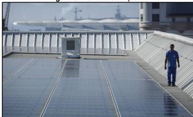
Figura 6: Telhado do AquaRio
