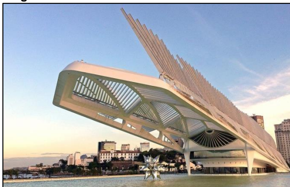
Figura 5: Hastes fotovoltaicas do Museu do Amanhã
