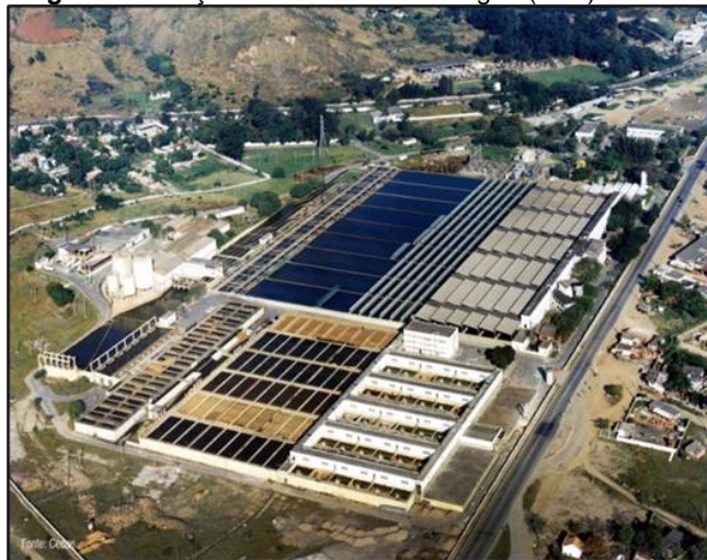
Figura 1: Estação de Tratamento de Água (ETA) Guandu
