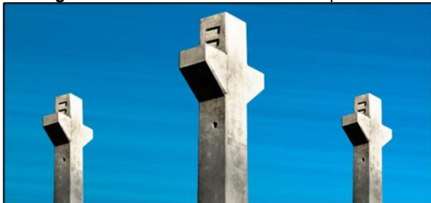
Figura 7: Pilares com dois consoles trapezoidais
