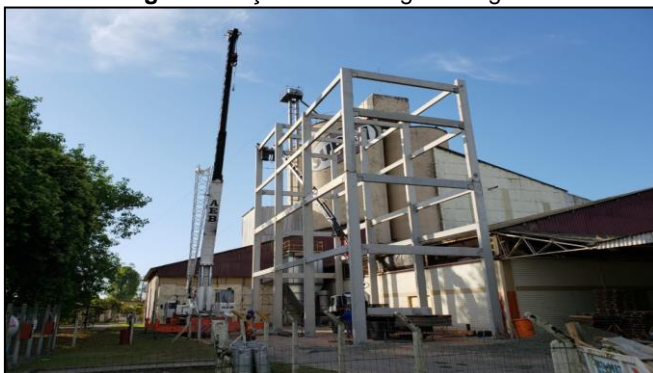
Figura 11: Içamento de viga retangular
