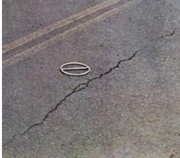
Figura 8: Trincas longitudinais
