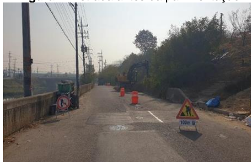
Figura 1: Estrada antes da pavimentação
