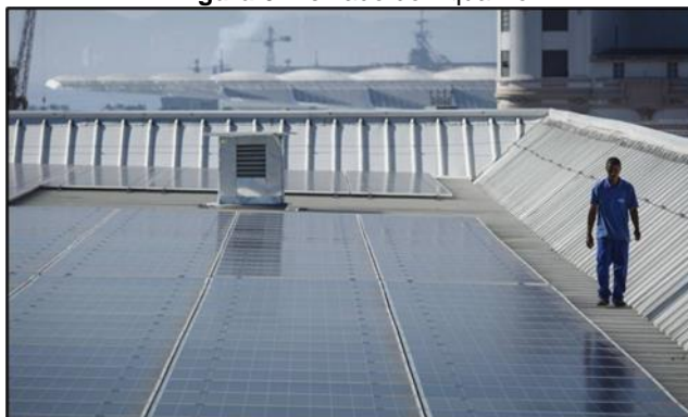
Figura 6: Telhado do AquaRio
