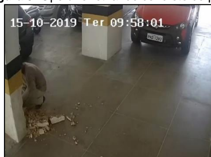
Figura 3: Operário retirando concreto do pilar
