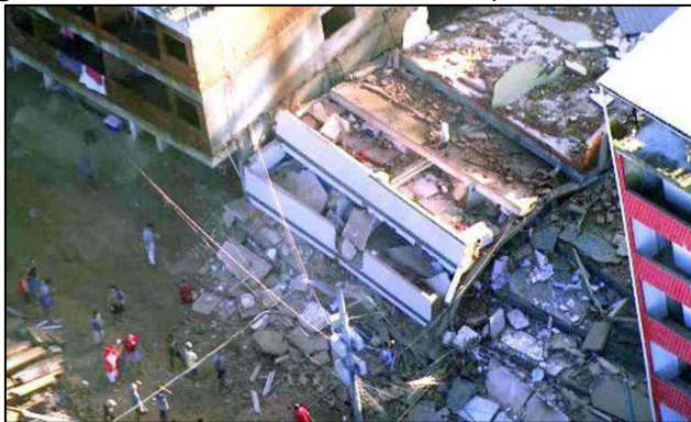
Figura 2: Local onde se encontrava os dois prédios em Muzema
