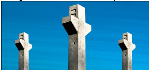
Figura 7: Pilares com dois consoles trapezoidais
