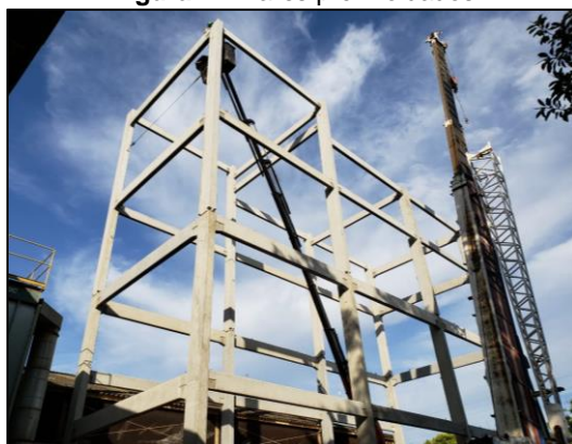
Figura 4: Pilares pré-moldados
