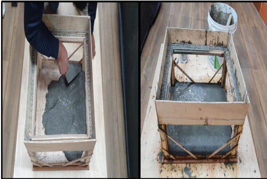
Figura 11 - Concretagem do piso, pilares e vigas
