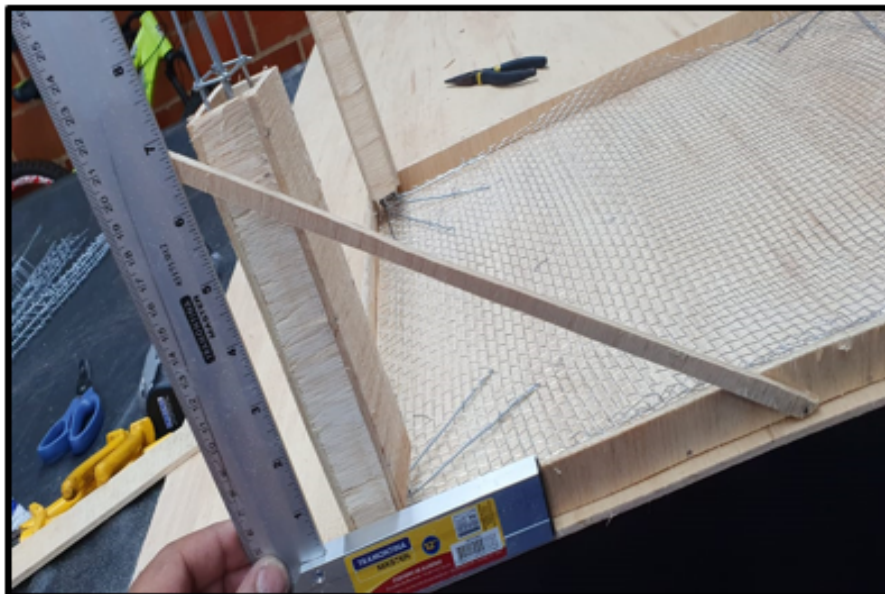
Figura 6 - Escoras de alinhamento dos pilares
