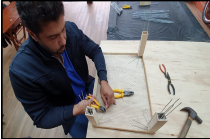
Figura 5 - Amarração dos pilares no piso
