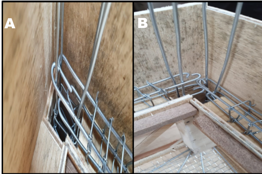
Figura 9 - Amarração das vigas
