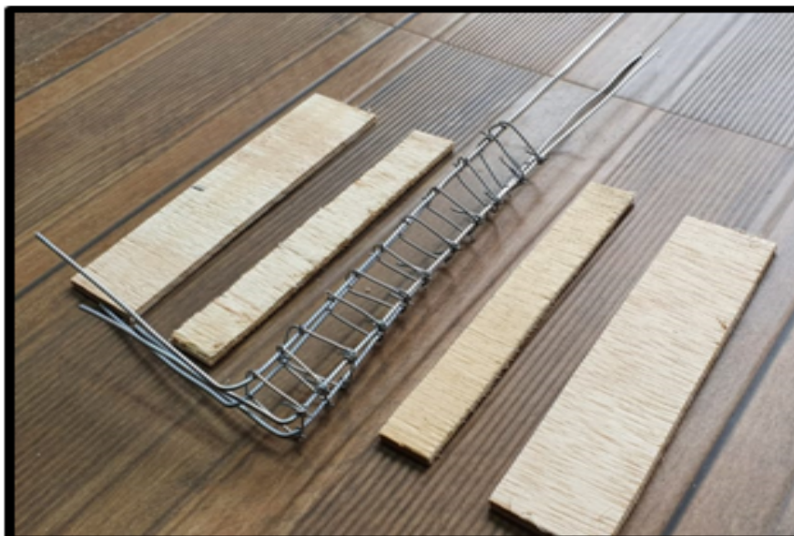
Figura 4 - Construção dos pilares de sustentação
