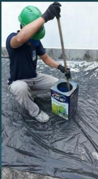
14. Parede preparada, “fitada” com fita crepe é chegada a hora da aplicação da tinta pelo pintor. O servente deve preparar esta tinta adicionando água na quantidade determinada pelo pintor e misturar até a homogeneização da mistura;
