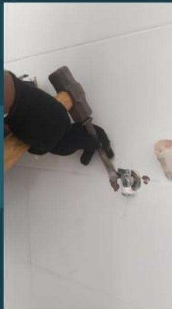
2. As ferramentas a serem usadas são a marreta, talhadeira e a ponteira. Quando necessário e permitido, o uso do martelete é crucial, para agilizar e dinamizar o trabalho de remoção;
