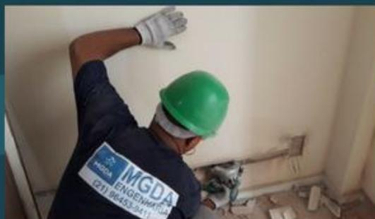
4. A partir destes cortes, agora com o uso da talhadeira e marreta o servente deve “esculpir” a alvenaria com a retirada das partes entre os cortes, formando assim as cavas onde serão instalados os conduítes;
