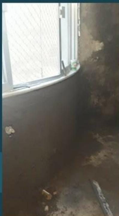
10. Parede erguida e preparada, chapiscada e emboçada, pronta para receber o revestimento, seja de pintura ou colagem de revestimentos cerâmicos. Mais um serviço importante do servente de obra, aqui em auxílio ao pedreiro.
