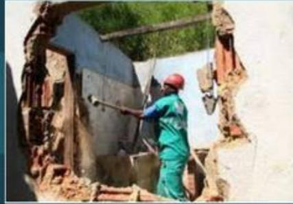
Na demolição manual utilizam-se ferramentas manuais de diferentes tamanhos. As principais são: marretas, talhadeiras, ponteiros e as ferramentas motorizadas de pequeno porte, como marteletes, com a utilização de diferentes ponteiros e talhadeiras acopladas.
