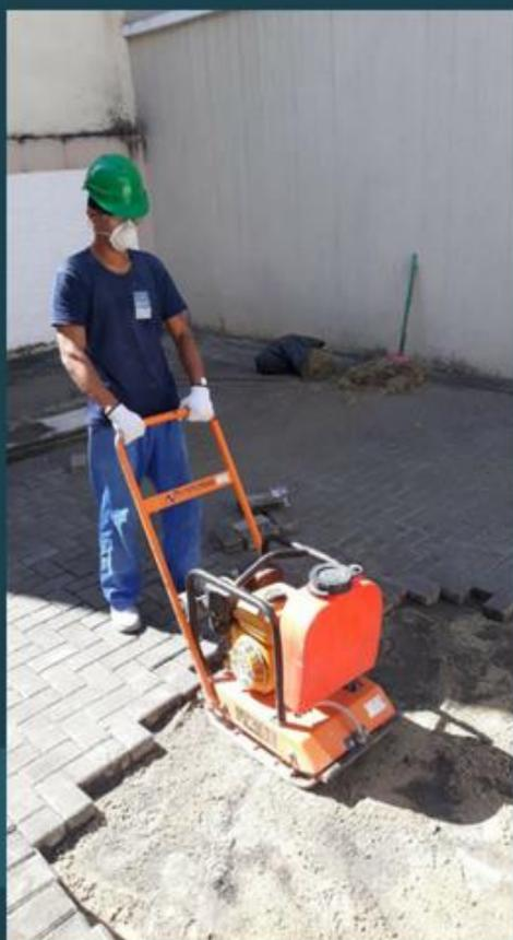
5. Material de base todo espalhado na área a ser pavimentada, de novo, com o uso da compactadora de solo, o servente deve compactar e regularizar a área;
