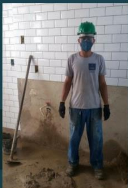
Servente com equipamentos de proteção individual (EPI's)
