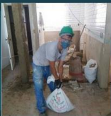
Saco com entulho
