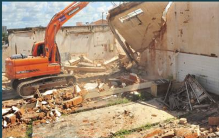
Demolição Mecânica
