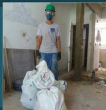
Empilhamento Sacos de Entulho
