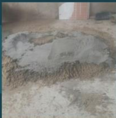
Adição de cimento sobre colchão de areia
