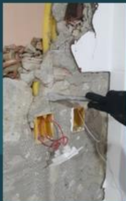
Remoção de caixa elétrica
