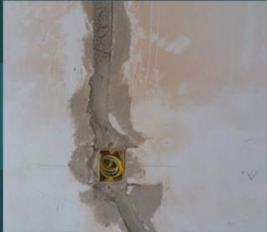
Cobertura dos conduítes com emboço
