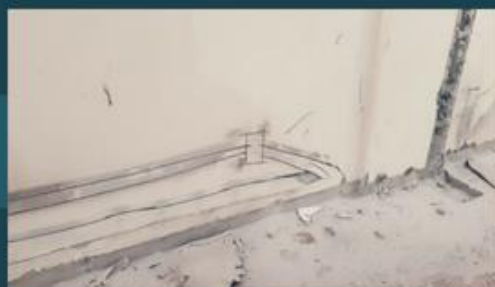
Locação das caixinhas e eletrodutos
