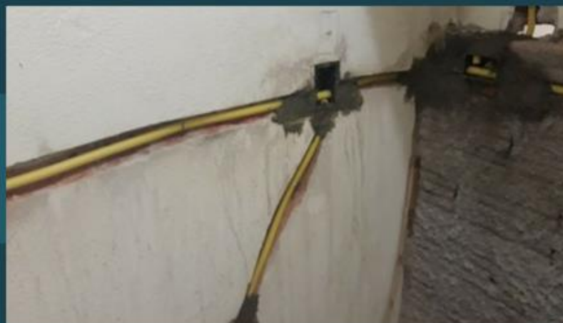
Fixação de caixinhas e conduítes
