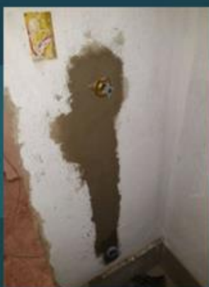
Fixação completa de canos e conexões com argamassa
