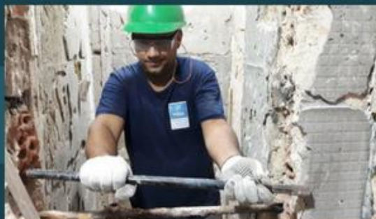
Remoção de Tubulações inteiras
