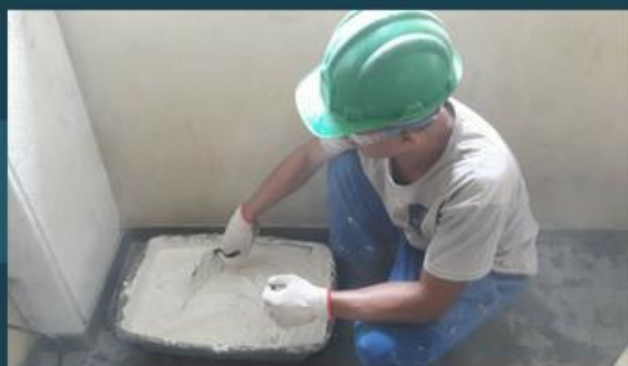
Preparo da argamassa
