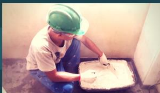
Preparo do rejunte
