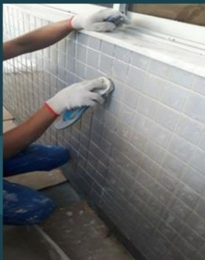
aplicação de rejunte
