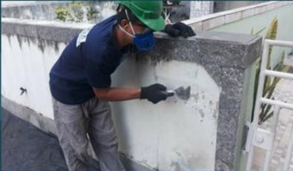
Raspagem da pintura antiga
