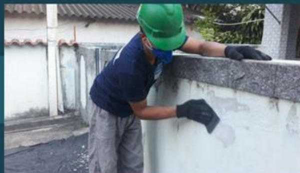
Lixamento da parede após a raspagem
