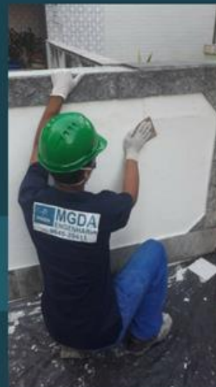
Lixamento da massa aplicada na parede
