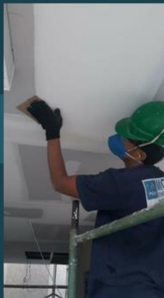
Lixamento de massa nas juntas
