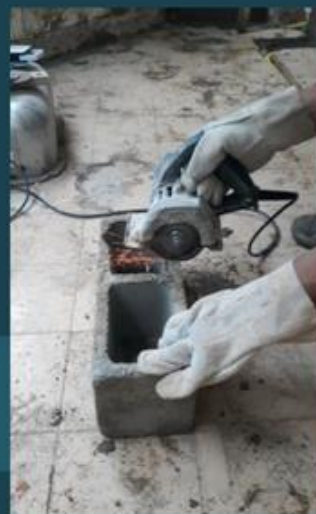
Corte de bloco de concreto com maquina
