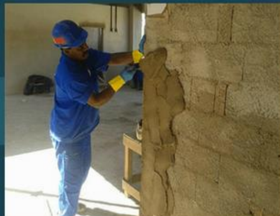
Aplicação de emboço
