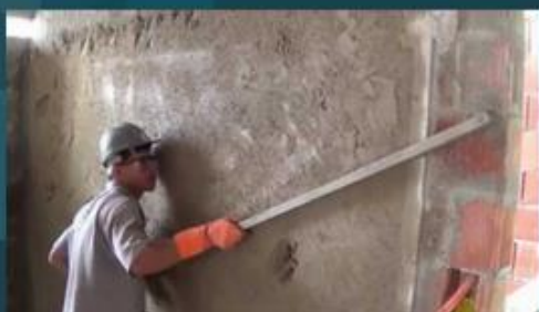
Alisamento com régua metálica
