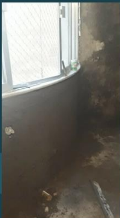
Parede preparada para revestimento
