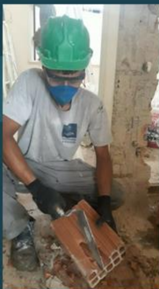
Corte de tijolo com colher de pedreiro
