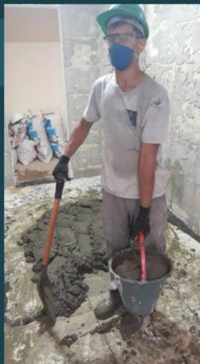
Transporte da argamassa pronta
