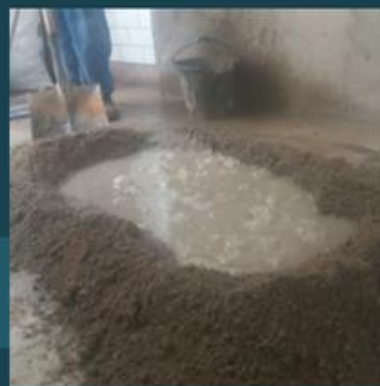
Preparo da argamassa
