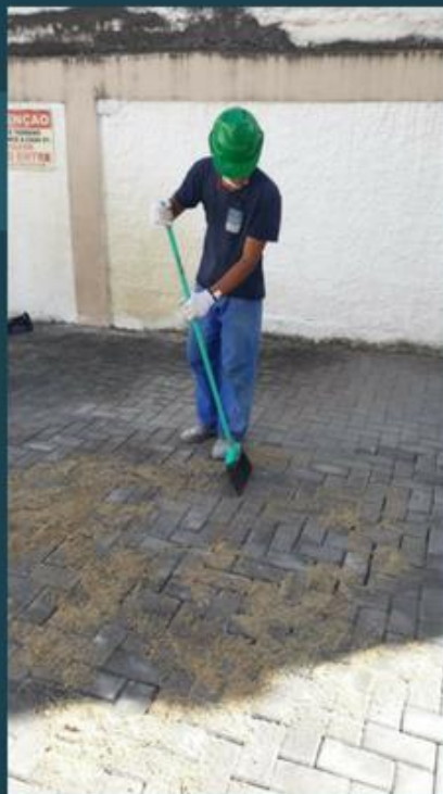
Rejuntamento de blocos
