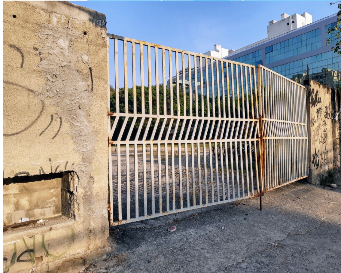
PORTÃO DE ENTRADA EXISTENTE
